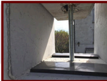
Vincoli antisismici delle travi ai pilastri
