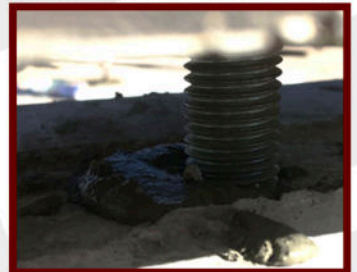
Vincoli antisismici dei pannelli di tamponamento
