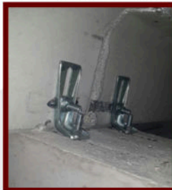
Vincoli antisismici dei tegoli alle travi
