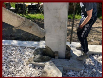
Inghisaggio dei pilastri nei bicchieri di fondazione con cls
